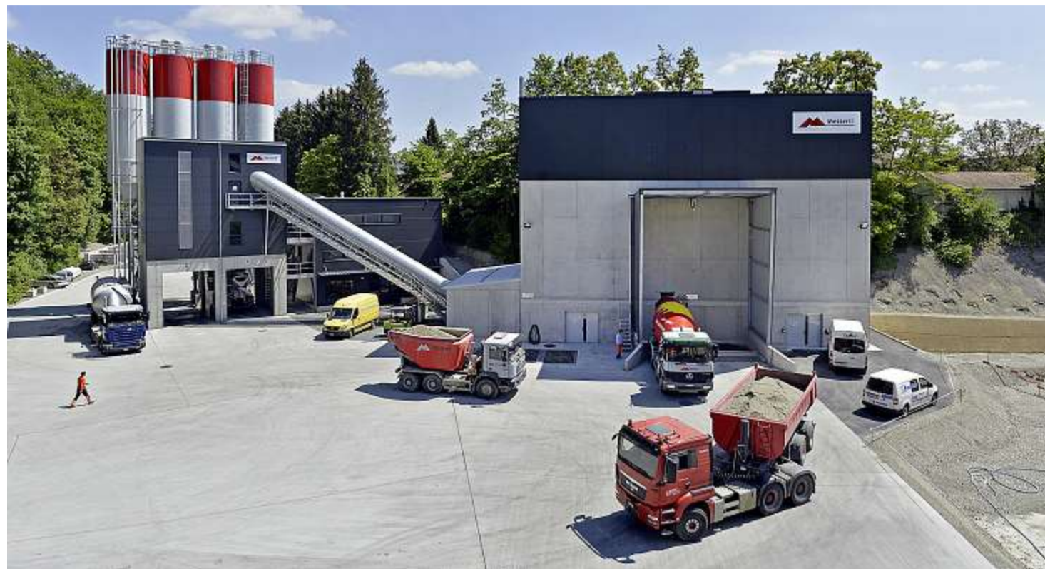
Von hier kommt der Berner Beton: Die neu gebaute Beton-Zentrale in der Messerli-Grube in Bern-Bethlehem.
